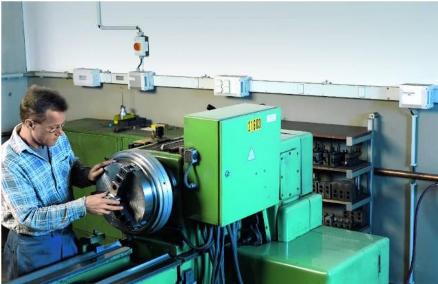
Szynoprzewód dystrybucyjny SIVACON 8PS BD2 od 63A do 1250A
